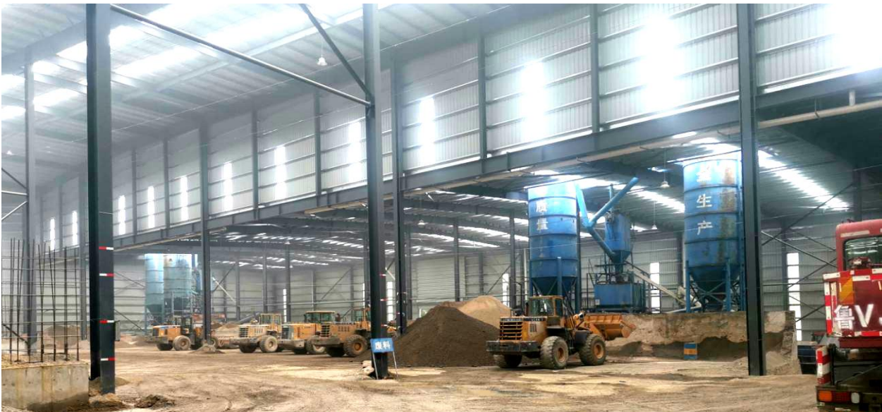
水稳拌合站生产车间照片
