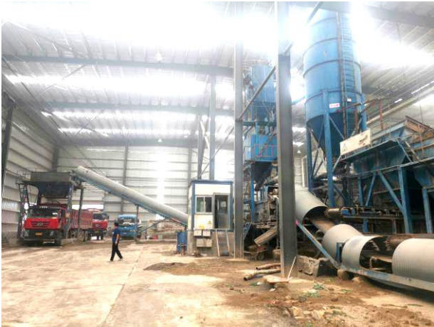
水稳拌合站（南）
