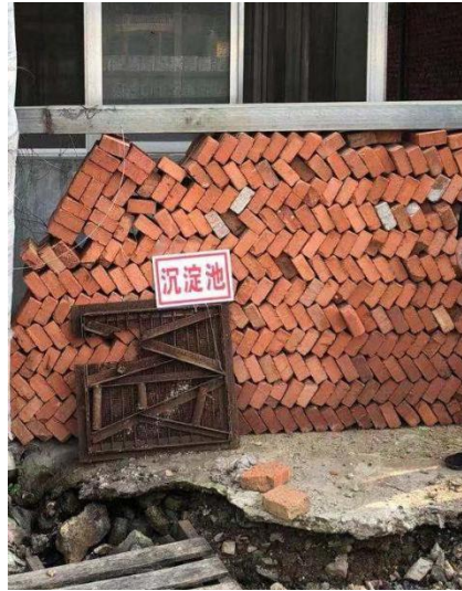
沉淀池检查口
