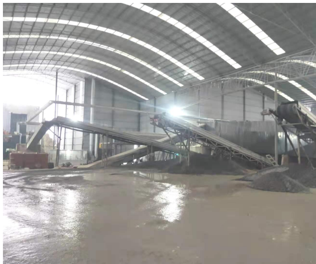
南车间石料破碎线
