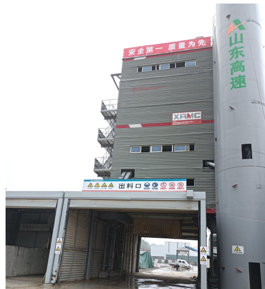
拌合站出料口
