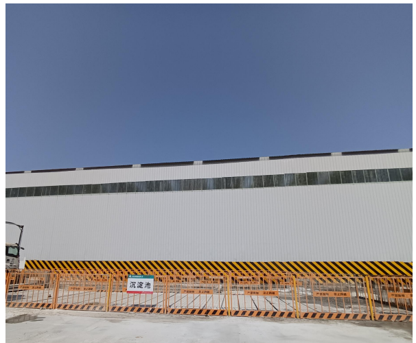
运输车辆冲洗水沉淀池
