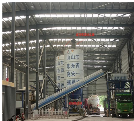
水泥罐及水稳拌合料出料口
