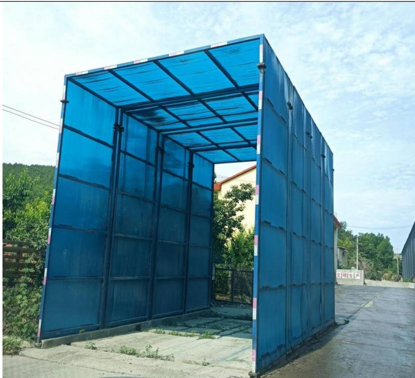
洗车平台及 2#沉淀池
