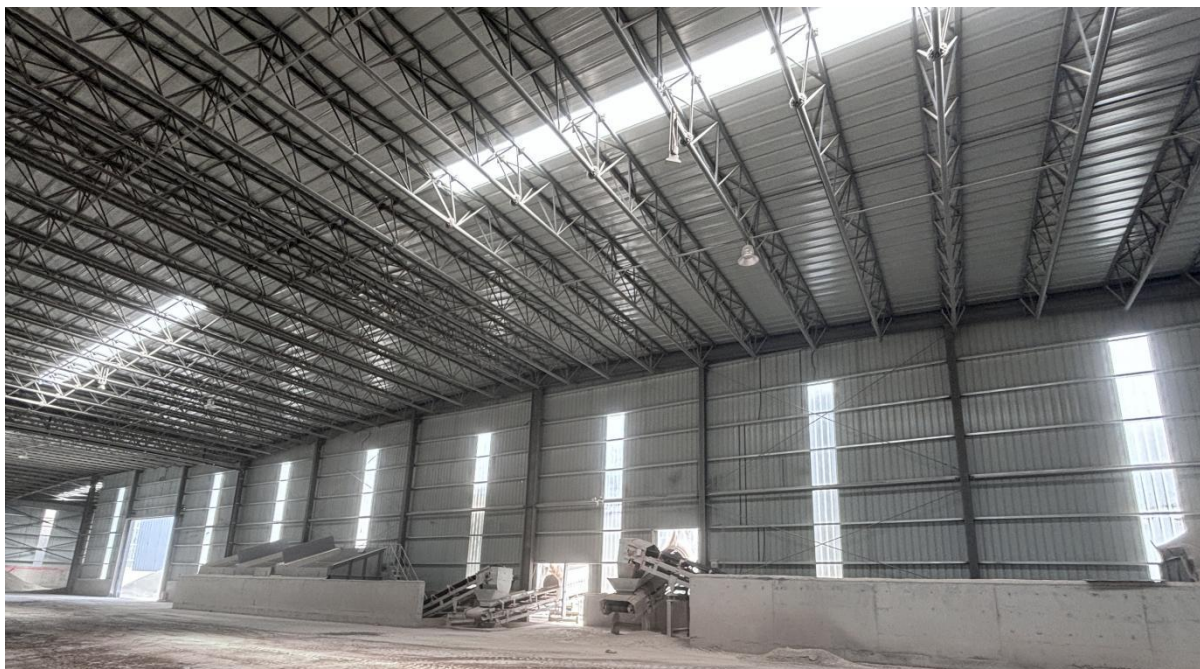
西厂区原料上料区
